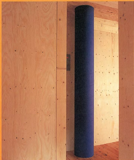
木造開放しの室内に OM立ち下がりダクトの色が映える。
