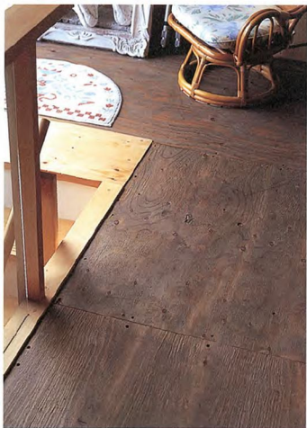
アトリエの床は構造用パネルのままの仕上げ。
